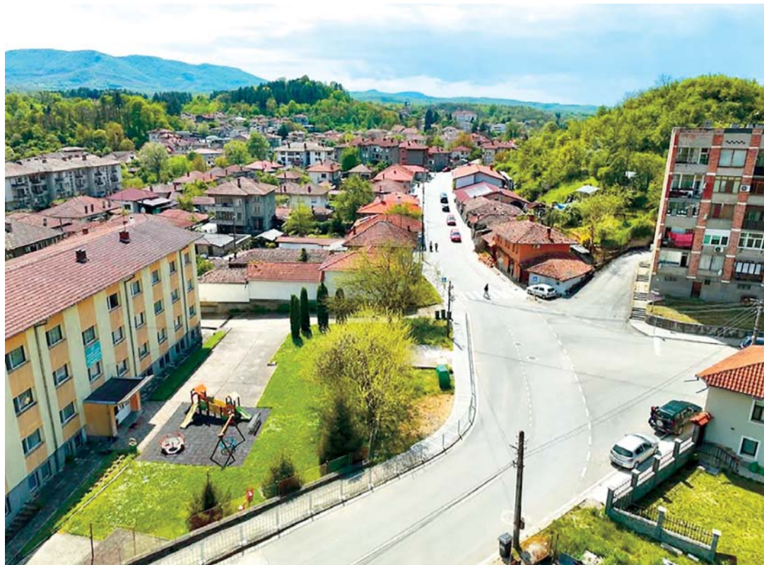
Ул. „Иван Момчилов“ е с подменени водопроводи и нов асфалт.
